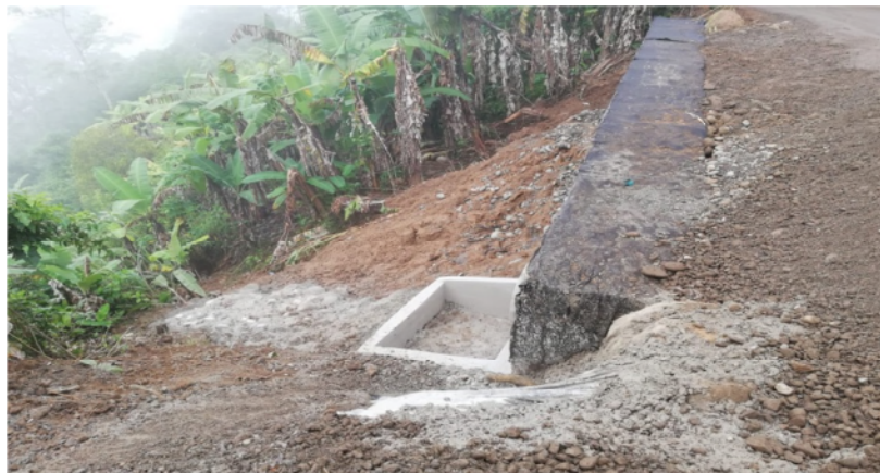
Fotografía N°1: Construcción de paso de tubería en El Silencio de La Suiza.
