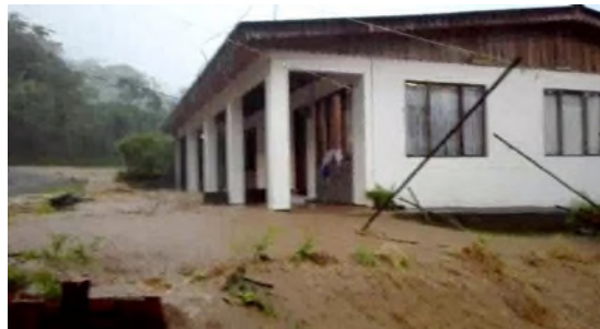
Imagen N°4: afectaciones que tenía la vivienda de Flory Rivera (firmante) antes de los trabajos, se aprecia el agua de desbordada en la carretera ingresaba a su vivienda y luego a la servidumbre.
