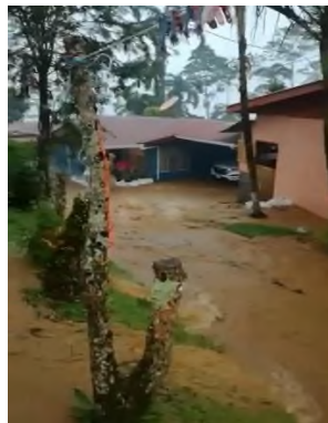
Imagen N°1: antes de los trabajos se aprecia como el agua desbordada tomaba la servidumbre de acceso a todas las viviendas de los vecinos firmantes .
