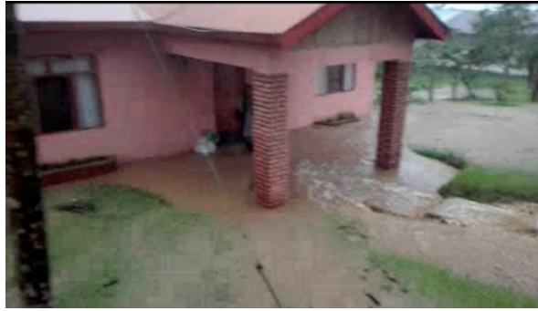
Imagen N°3: afectaciones que tenía la vivienda de Juan Carlos Contreras antes de los trabajos, se aprecia la colocación de sacos para evitar que el agua que se desbordaba ingresara.
