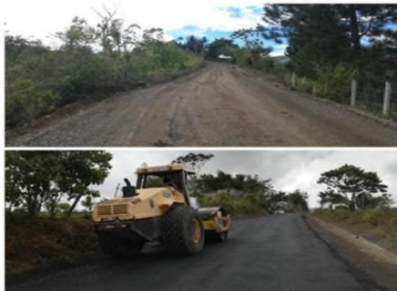
Fotografía N°1: Pendiente estabilizada camino público 03-05-014 La Selva – Las Colonias.
