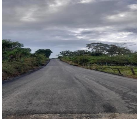
Fotografía N°7: Estabilización de pendiente en el camino público Palomo – El Cas - Líbano.
