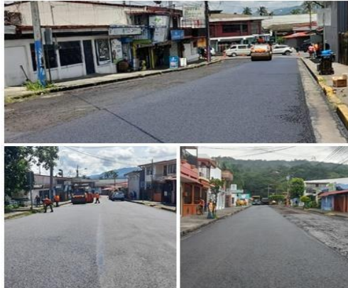
Fotografía N°32: Reconstrucción de pavimento calles y avenidas.
