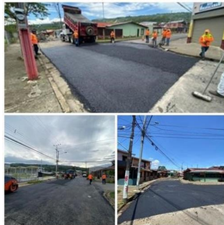
Fotografía N°4: Trabajos en cuadrantes urbanos.
