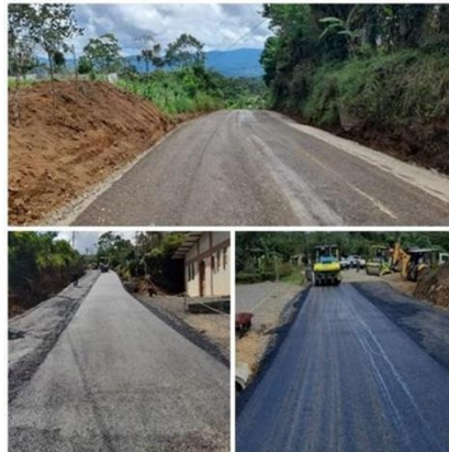
Fotografía N°2: Trabajos en el camino Bellavista – El Cas.
