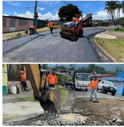
Fotografía N°6: Bacheo formal Carmen Lyra.
