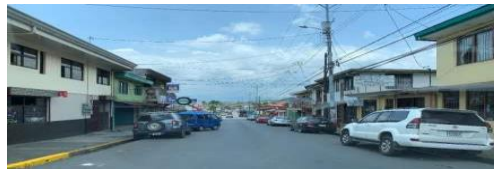
Figura 71 Ausencia de señalamiento horizontal Ruta Nacional N° 10
