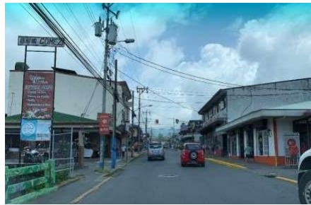
Figura 70 Ausencia de señalamiento horizontal calle 2
