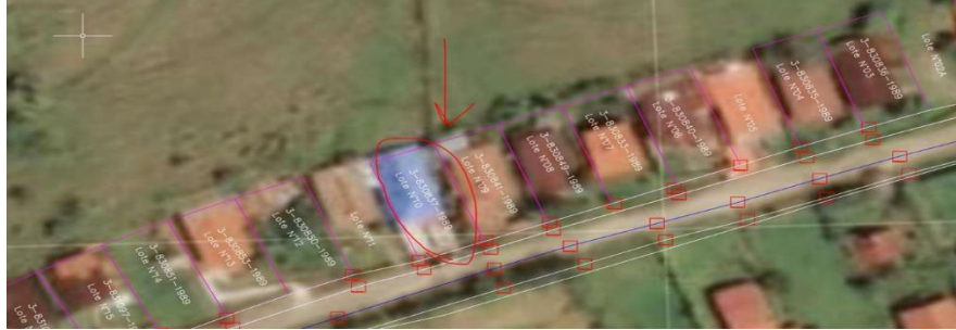
IMAGEN 2: Flujo de aguas hacia la colindancia de la señora Nora, la residencia presenta problemas de socavación en sector noreste de vivienda. (plano C-830837-1989)
