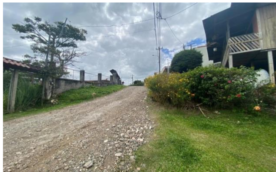
Fotografía N°2: evidencia de obstáculos en sectores donde debe ir aceras.
