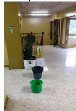
Pasillo por el Balcón
